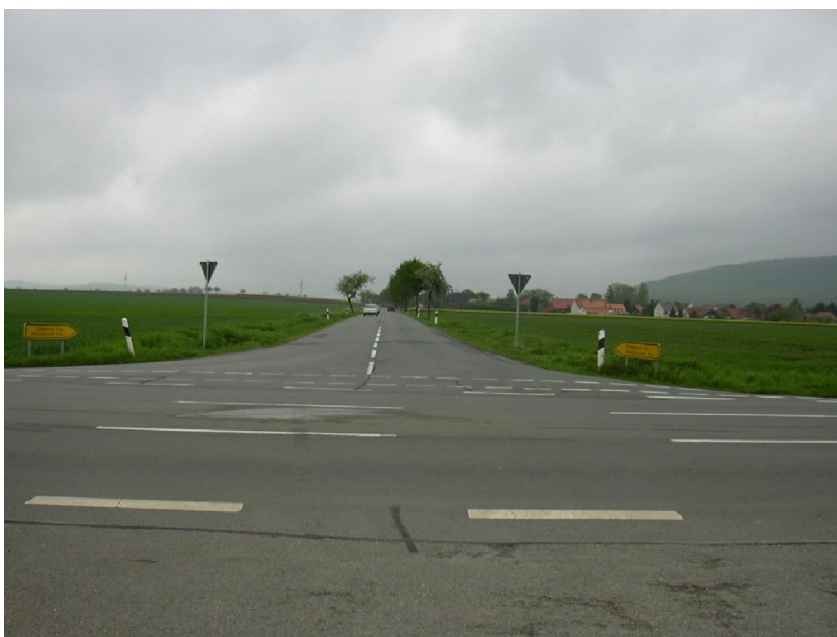
Abbildung 1: Kreisstraße K 415 Blick in Richtung Osten
